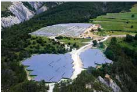
1.0 MW solar power plant, Le Lauzet, France
